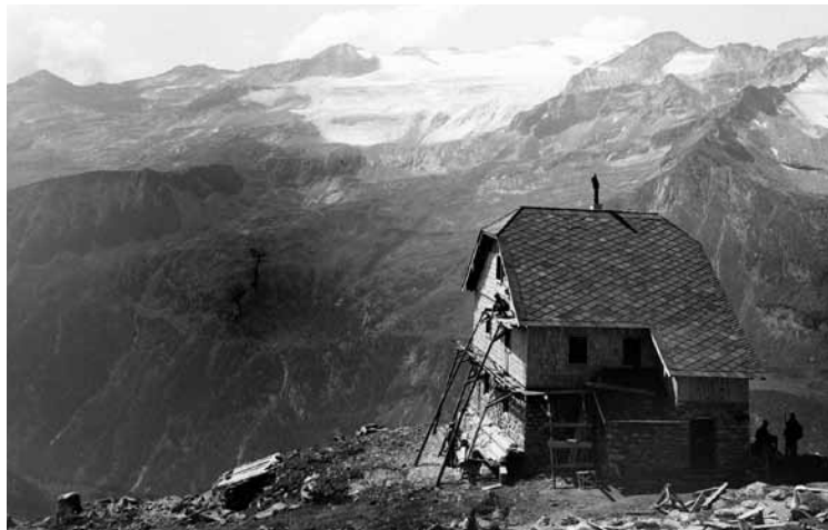
Die Kattowitz Hütte im Bau, 1929
