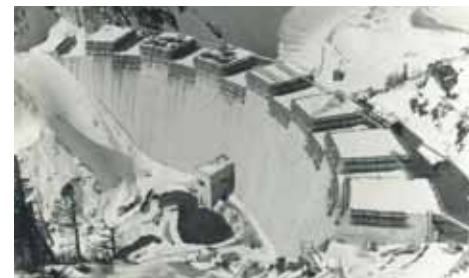
Mit dem Bau der Kölnbreinsperre erfolgte der wohl gravierendste Eingriff in die Naturlandschaft des hintersten Maltatals – das Foto ist etwa 1975 entstanden.
