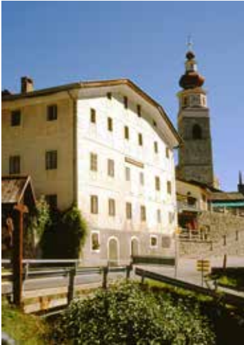
Der Gasthof Bäckwirt ist neben der Wallfahrtskirche eines der ältesten Gebäude in Maria Luggau.
