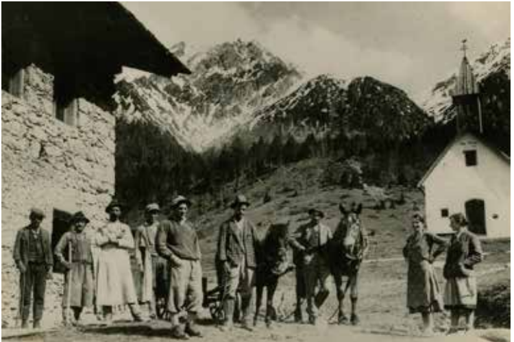
Der Arbeitertrupp nach Fertigstellung des Tuffbades, um 1933
