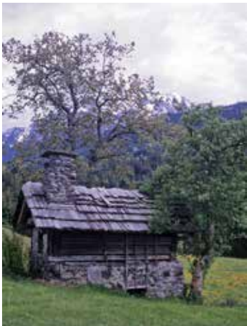
Brotbackofen beim Stabentheiner Hof
